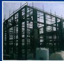
مسجد فرودگاه بین المللی قشم (EPC)
