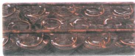
شکل مخزن ذخیره‌ی سرمایی سیستم یخ‌سازی بر روی کویل (خارجی)
